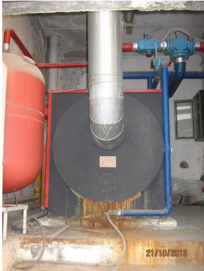
Il bruciatore che alimenta la caldaia stessa ha una potenzialità di 300 kW
